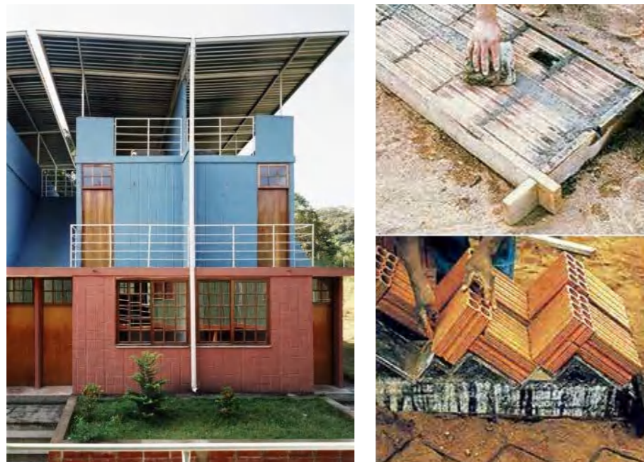
figuras 19, 20, 21 conjunto habitacional Cotia por Joan Villà e Silvia Chile - imagens da implantação, unidade habitacionais e fabricação de painéis cerâmicos
