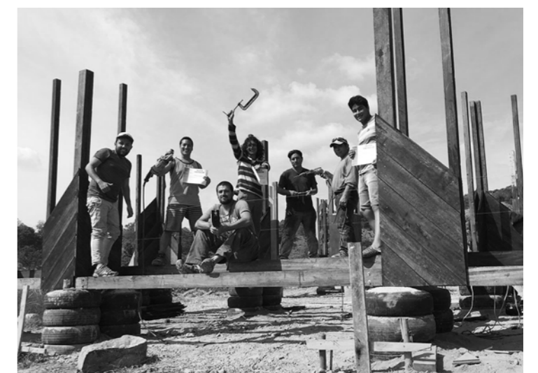
figura 38 execução da habitação rural
