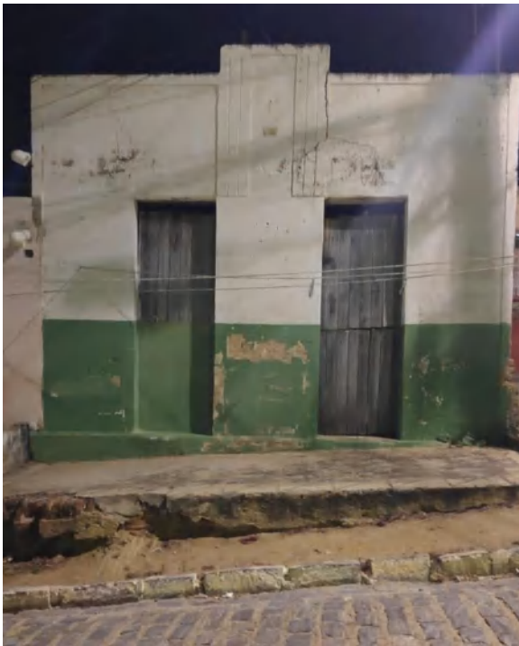
Figura 28 - Antiga casa do motor à diesel.
