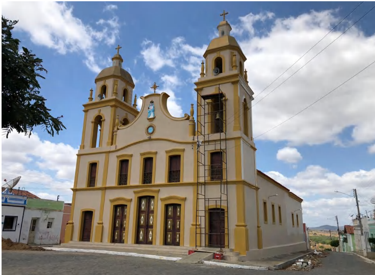
Figura 72 - Reparos na fachada da Igreja de Nossa Senhora da Conceição.
