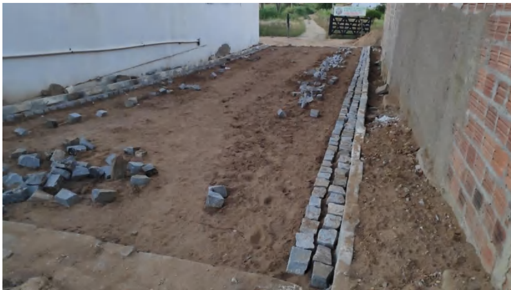
Figura 73 – Processo de calçamento. Rua sem nome.
