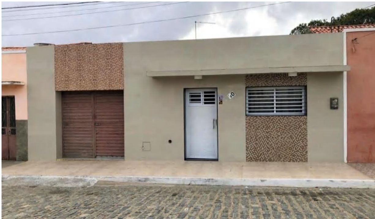
Figura 54 - Casa com revestimento cerâmico na fachada inteira.
