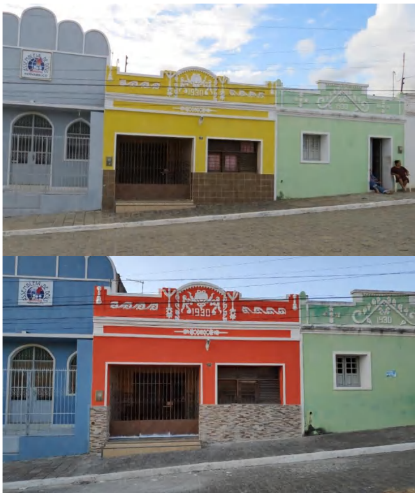
Figura 55 - Painel de fotos de uma residência com revestimento cerâmico parcial.
