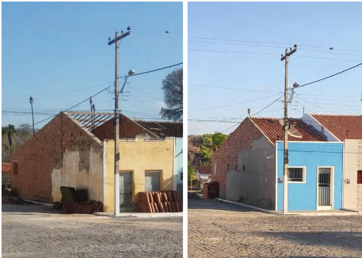
Figura 67 - Reforma em uma residência da Rua do Comercio.
