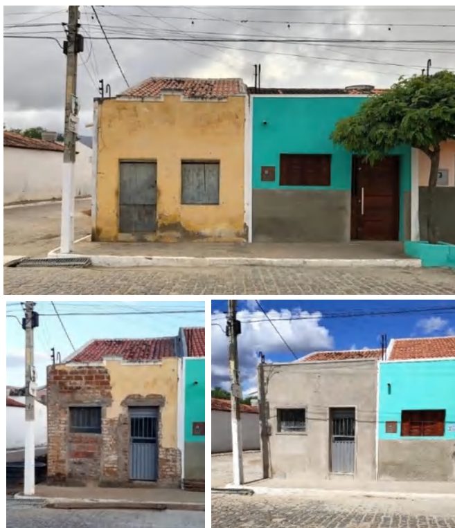
Figura 66 - Reforma em uma residência da Rua do Comercio.
