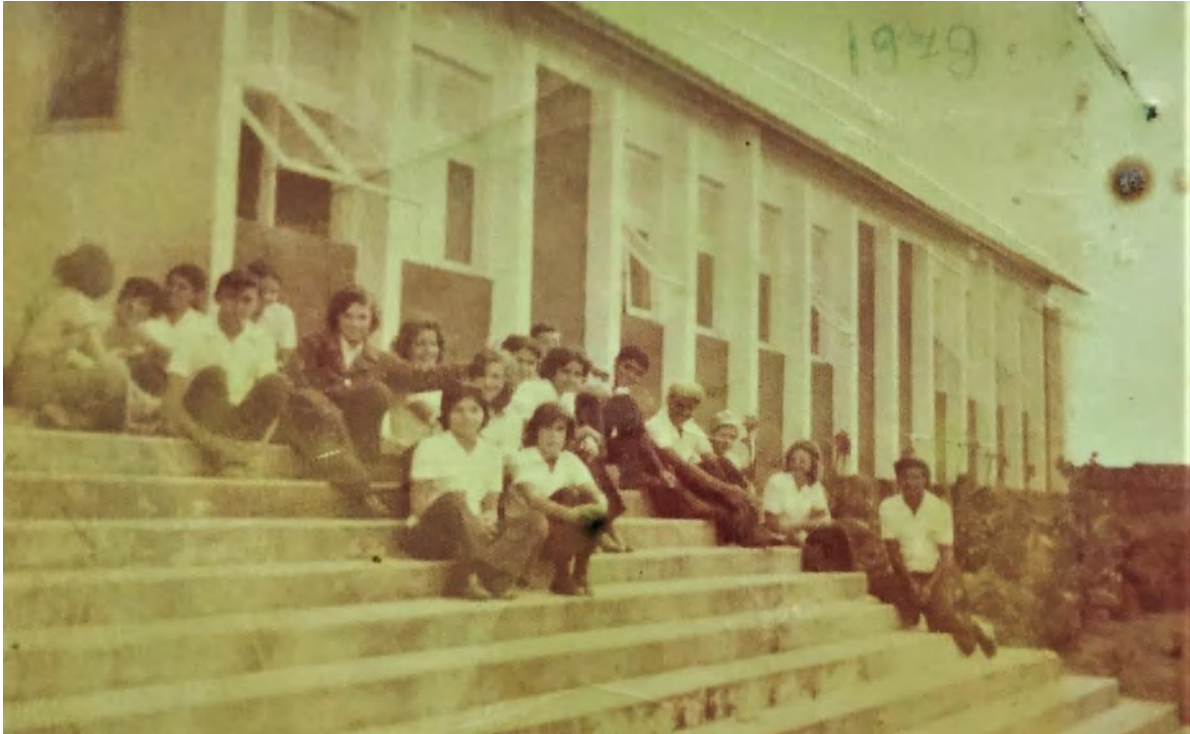
Figura 20 - Escola Municipal Padre Ibiapina.
