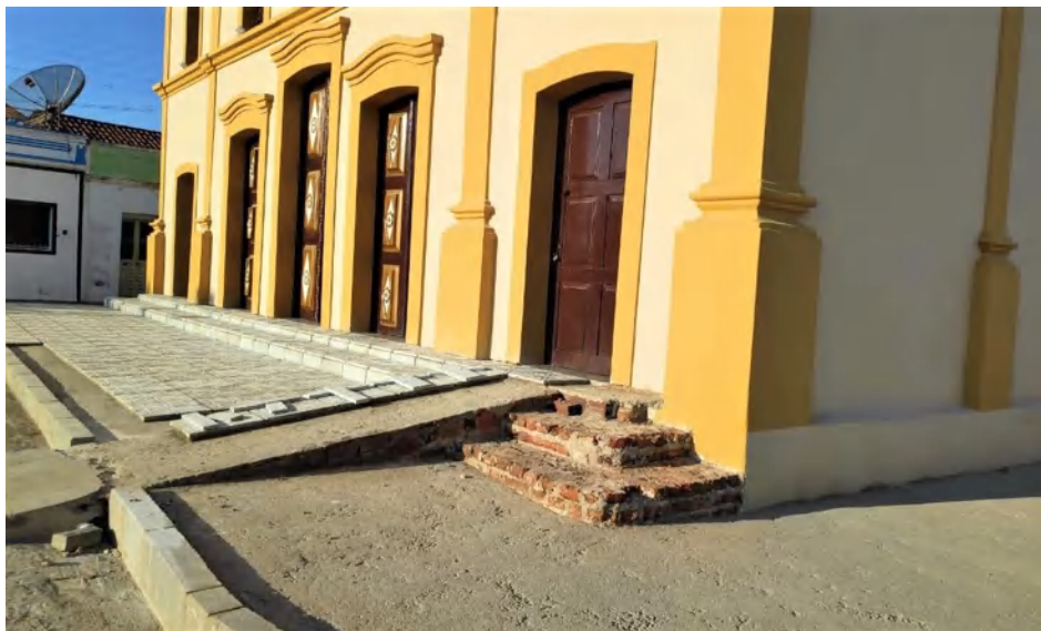
Figura 71 - Reforma do piso externo da Igreja de Nossa Senhora da Conceição.
