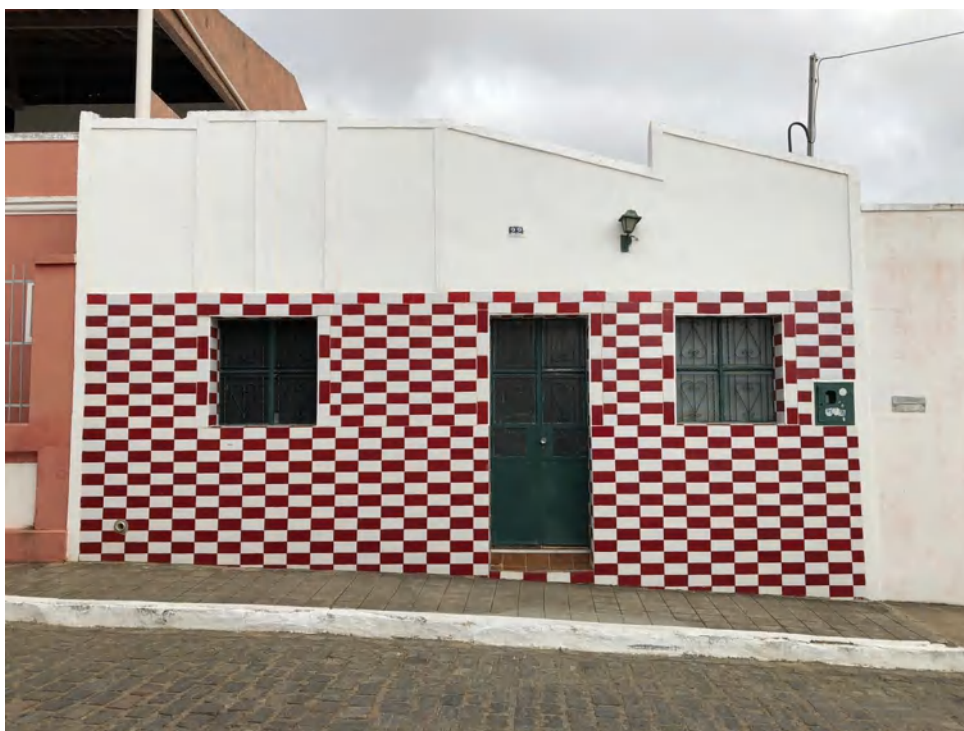
Figura 57 - Residência da Rua Martins da Cunha.
