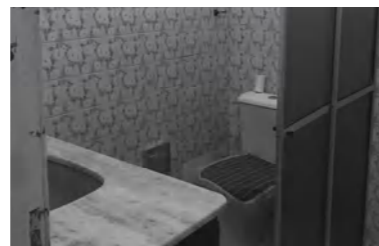
FIGURA 59 — Banheiro - Centro Comunitário Deixai Vir.
