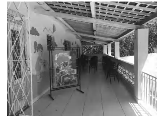
FIGURA 45 — Pinturas nas paredes do Centro Comunitário Deixai Vir.
