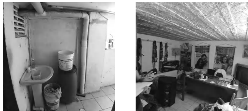
FIGURA 49 — Espaço de apoio da zeladoria - Centro Comunitário Deixai Vir.
