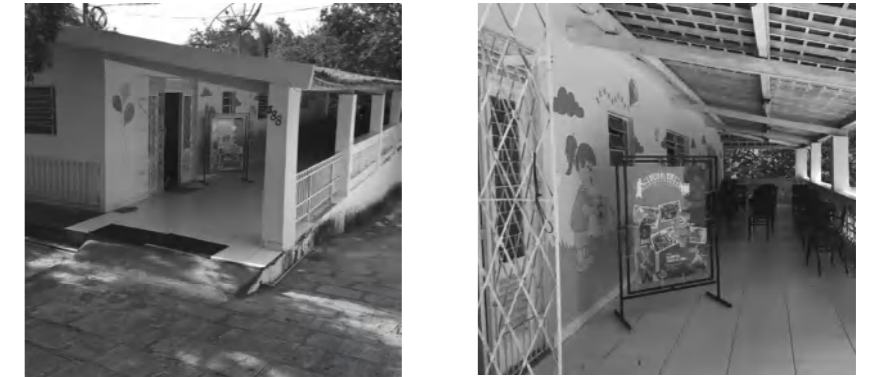
FIGURA 53 — Entrada para residência e Alpendre - Centro Comunitário Deixai Vir.
