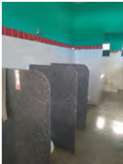
FIGURA 31. Banheiros da CRECHE Prof. Marivalda Cassimiro dos Santos.
