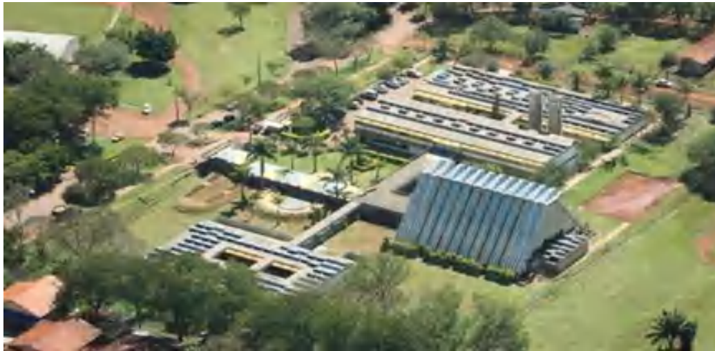
FIGURA 04. edifício de aplicação pedagógica da universidade estadual de Maringá (antigo CAIC). Imagem. Fonte: http://www.mgauem aplicacao.seed.pr.gov.br/modules/conteudo/conteudo.php?conteudo=1/ Acesso Setembro 2020
