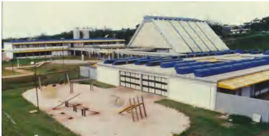
FIGURA 03. Perspectiva: Edifício de aplicação pedagógica da universidade estadual de Maringá (antigo CAIC). Imagem. Fonte: http://www.mgauemaplicacao.seed.pr.gov.br/modules/conteudo/conteudo.php?conteudo=1/ Acesso: Setembro 2020
