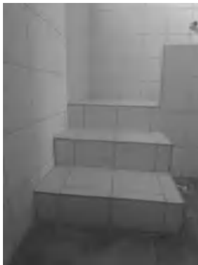
FIGURA 32. Banheiros da CRECHE Prof. Marivalda Cassimiro dos Santos.
