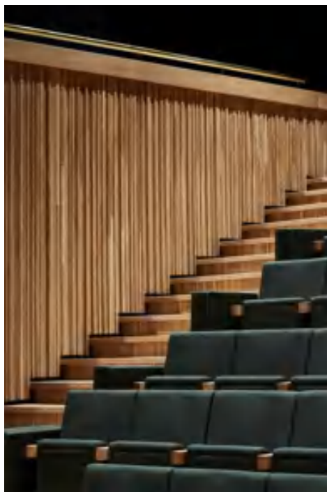
Figura 3.13: Detalhe da superfície irregular que ajuda a difundir o som no ambiente.
