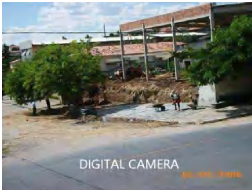
Figura 5.12: Processo de aterramento e planificação do terreno.
