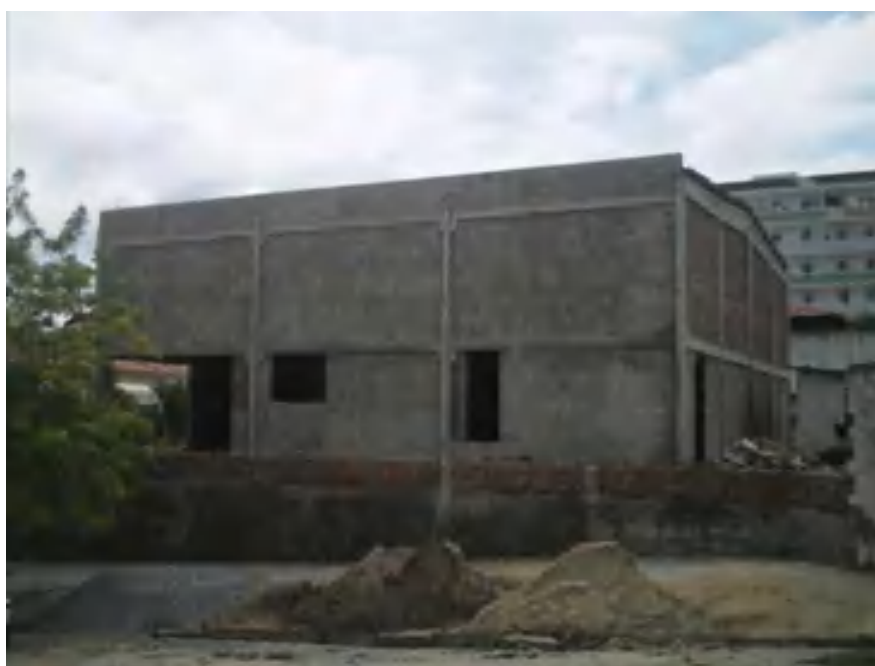
Figura 5.13: Imagem após a conclusão do muro de contenção do aterro.
