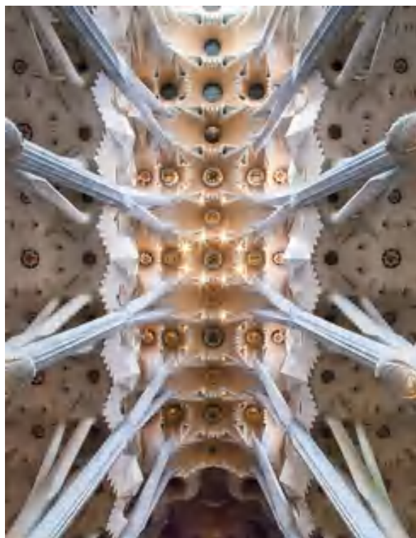
Figura 2.9: Esquema de difusão sonora em superfícies irregulares.
