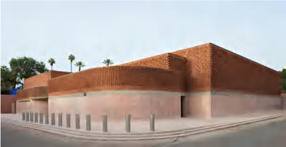
Figura 3.5: Fachada nordeste do museu.
