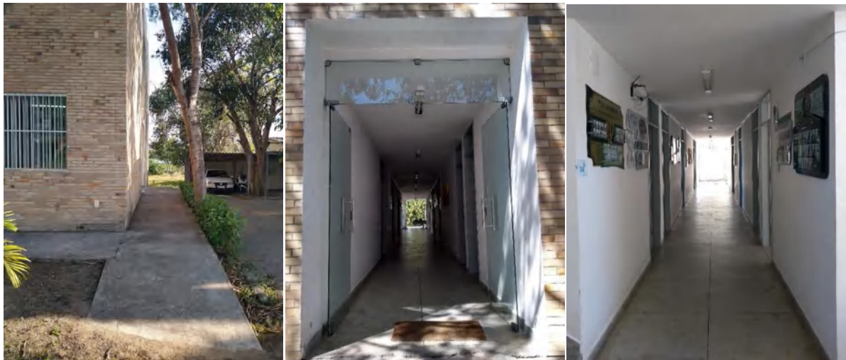
Figuras 55, 56 e 57. Acesso à entrada secundária, entrada secundária e corredor de circulação no pavimento térreo Fonte: Acervo pessoal (2019)
