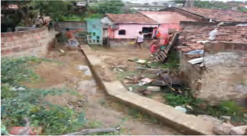
FIGURA 14: VILA DOS TEIMOSOS, 2013. FONTE: DEFESA CIVIL CAMPINA GRANDE.
