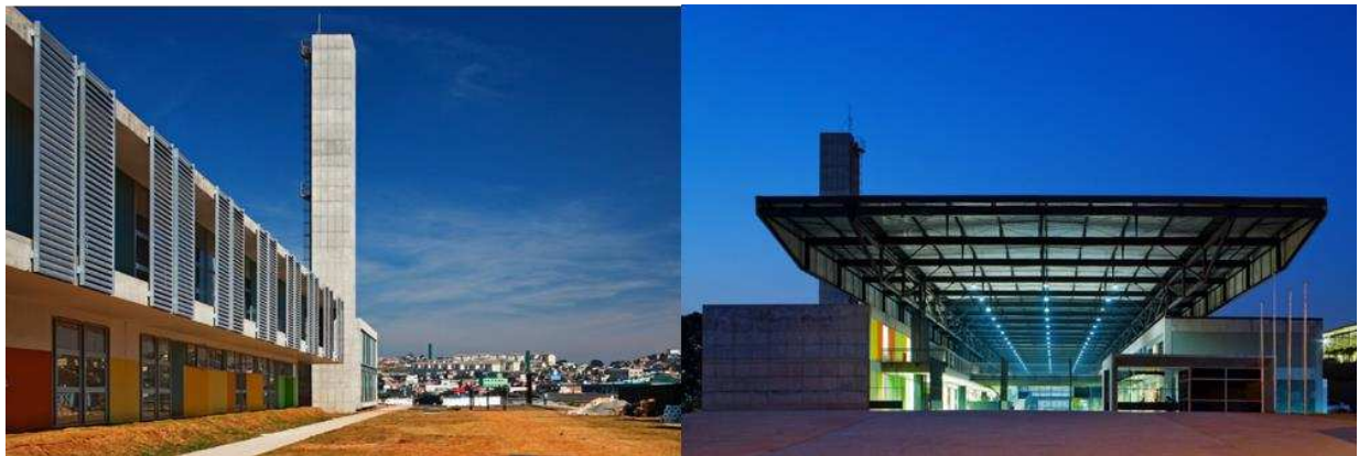
Figura 18: Destaque para os brises de alumínio e coberta metálica.
