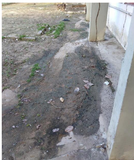
Figura 24: Região úmida próximo ao pilar
