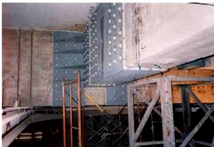
Figura 22: Reforço estrutural com chapas de aço coladas.
