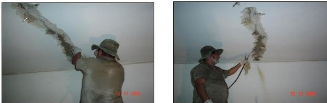
Figura 15: Processo de injeção de fissuras.
