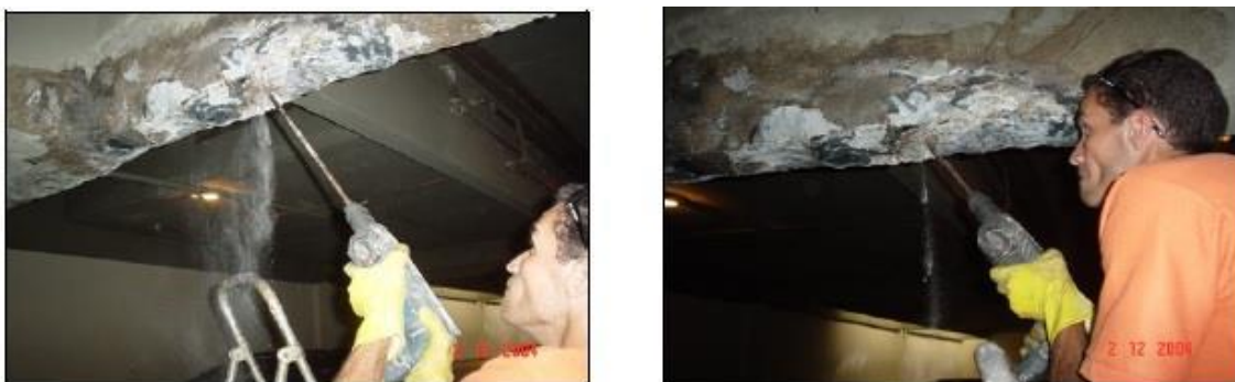
Figura 14: Processo de furação para colocação dos tubos de injeção.
