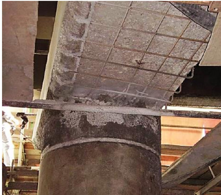
Figura 19: Viga preparada para receber reforço com concreto projetado
