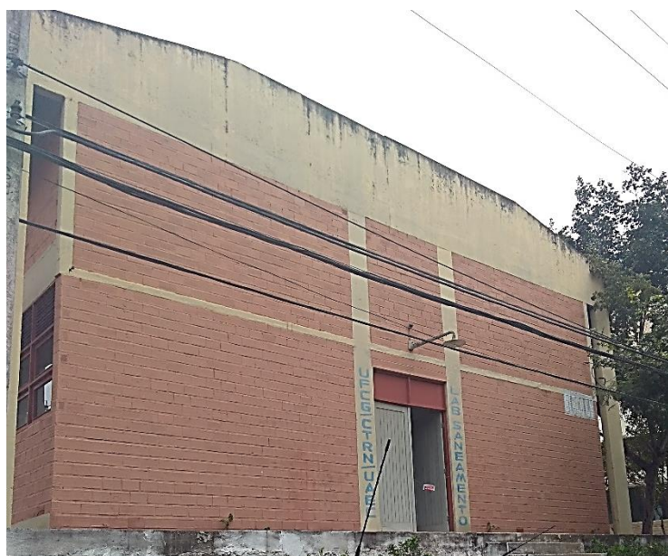
Figura 29: Vista frontal do Bloco CV
