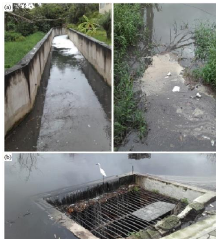
Figura 19 - Pontos de entrada (a) e saída (b) da água do açude.
