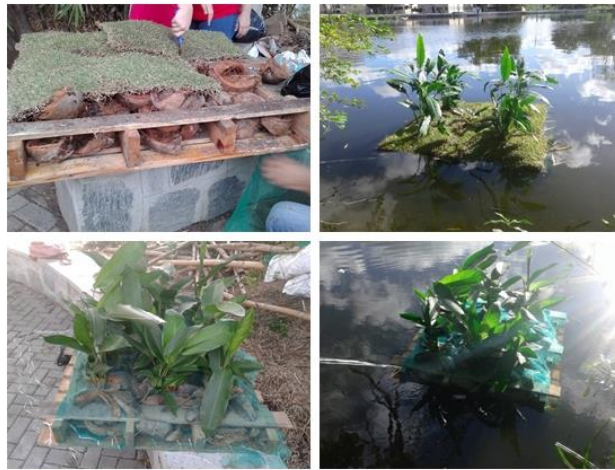
Figura 15 - Jardins flutuantes montados com suporte de paletes
