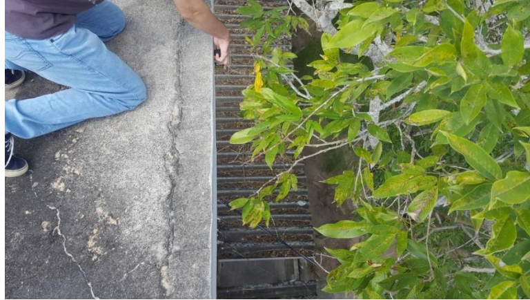
Figura 19: Medição da altura do bloco CL
