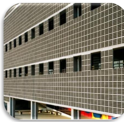
Figura 2: Cobogós instalados
