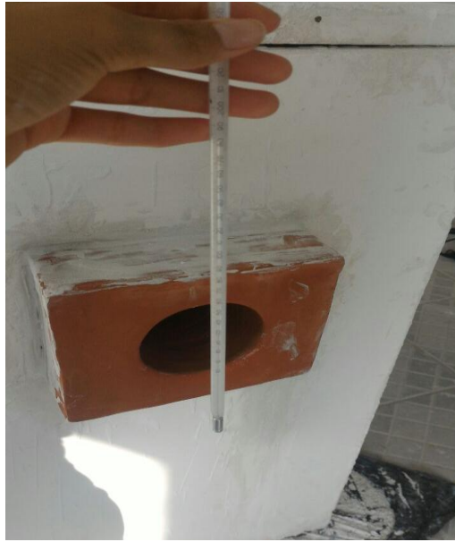
Figura 23: Medição de temperatura na face externa do cobogó
