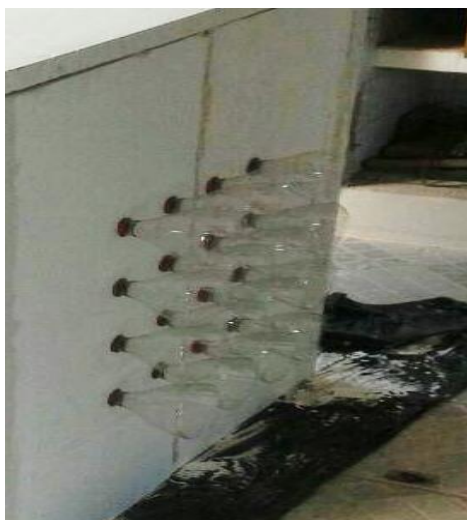
Figura 13: Garrafas “pets” cortadas e já instaladas na placa de gesso
