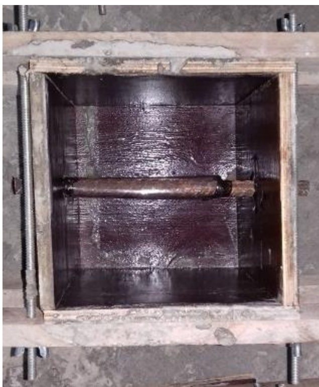
Figura 34 - Barra de aço posicionada no interior da forma
