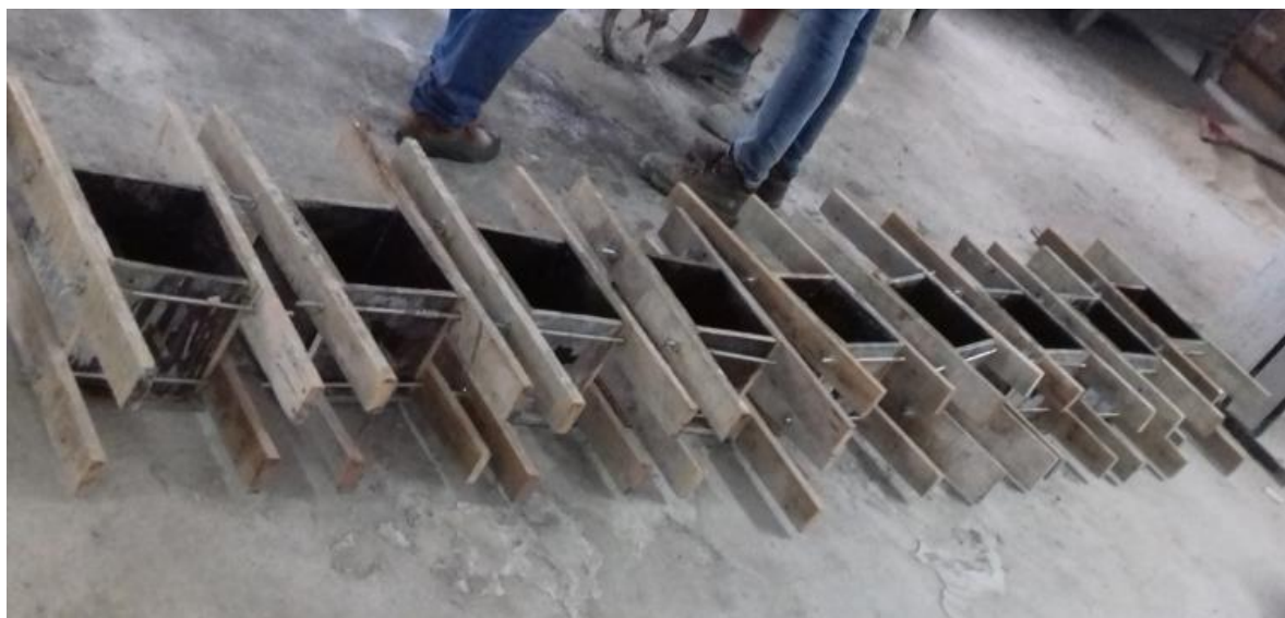
Figura 36 - Formas antes do preenchimento com concreto
