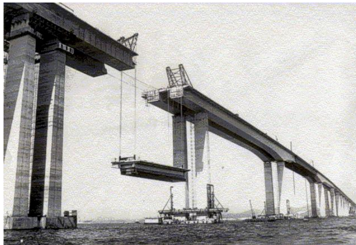
Figura 1 - Vão central da ponte Rio-Niterói
