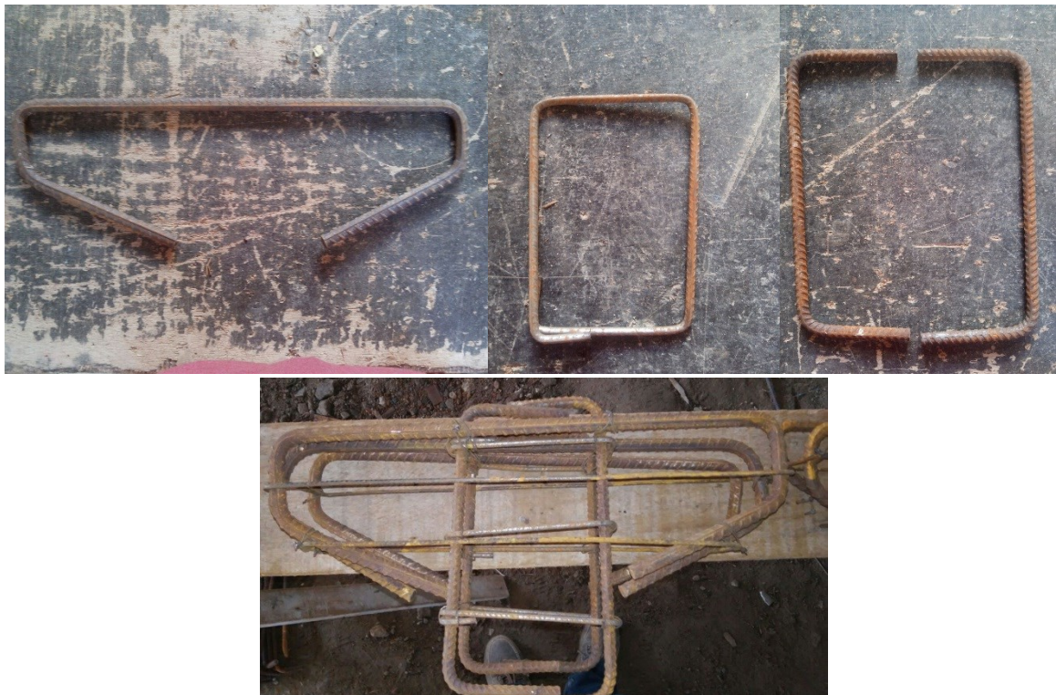
Figura 31: Armadura dos consolos
