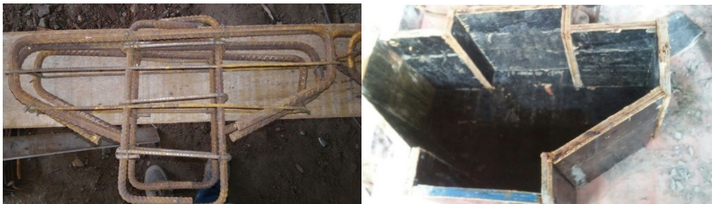
Figura 36: Passo 1 - Armadura montada e fôrmas
