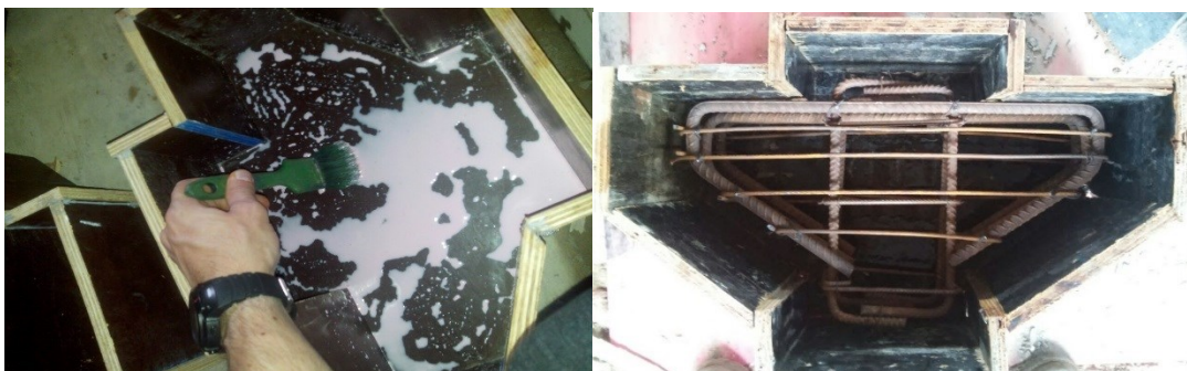
Figura 37: Passo 2 - Aplicação do desmoldante e posicionamento da armadura
