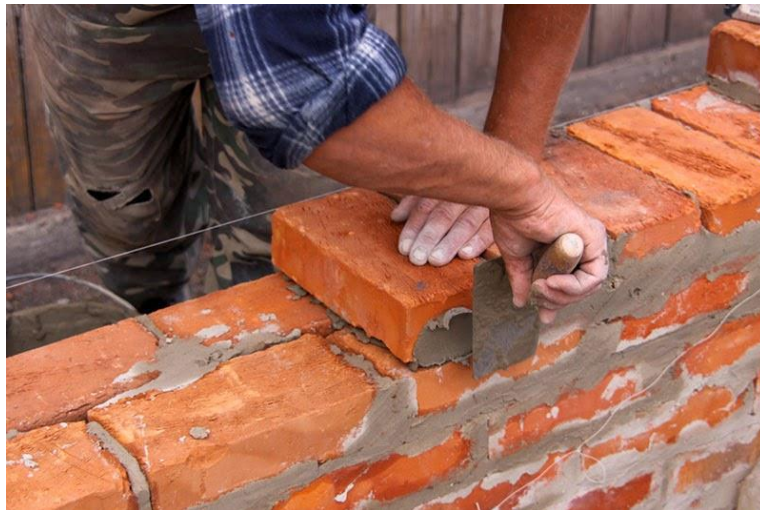
Figura 1: Aplicação de argamassa em assentamento de alvenaria em obra.
