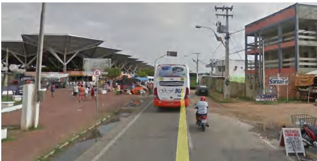
Figura 51 – Trecho 4 da rua São Pedro.
