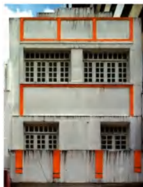
Imagem 18: Molduras de retângulos repetidos e aglutinados na platibanda (justaposição), um só abaixo, e repetidos aos pares por espelhamento na sacada (sobreposição). Janelas originais. Prédio comercial no centro de Campina Grande, PB, provavelmente da segunda década de 1940. Fonte: Lia Monica Rossi e José Marconi Bezerra de Souza
