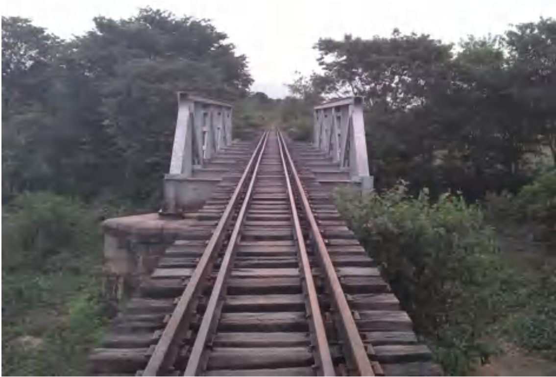
FIGURA 2: Ponte Ferroviária sobre o Rio Salgado, Missão Velha.
