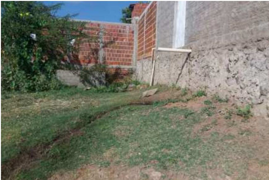
Figura 14 – Ligação clandestina de esgoto para dentro do Açude Major Marinheiro (Açude da Fome), município de Jardim de Piranhas/RN, 26/08/2016
