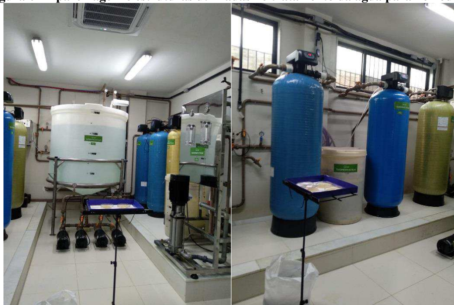
Figura 6 - Aparelhagem e estruturas utilizadas no tratamento da água para hemodiálise.
