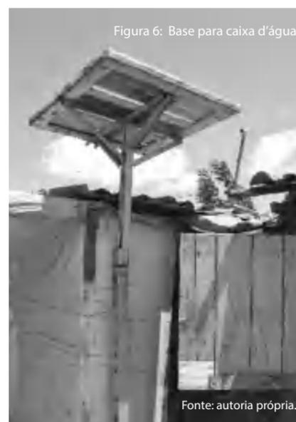
Figura 6: Base para caixa d'água
