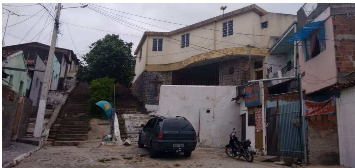
Fotografia 39, 40 e 41: Travessa São Jacinto, destaque para as calçadas desniveladas e para a escadaria de acesso. Fonte: Pesquisa de campo, abril de 2016.
