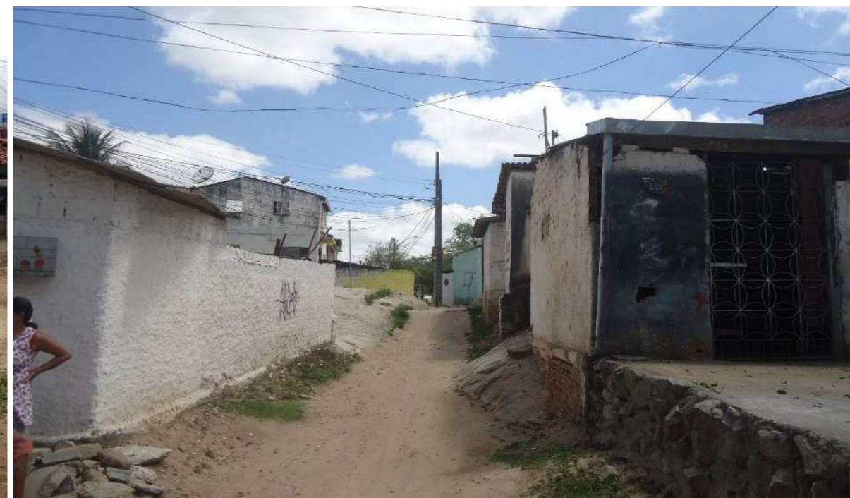
Fotografia 37 e 38: Rua Severino Verônica, destaque para a ausência de pavimentação, largura da via e calçadas desniveladas. Fonte: Pesquisa de campo, abril de 2016.
