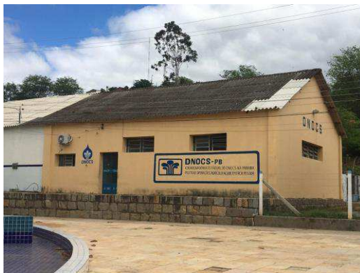
Sede do DNOCS-PB, Departamento Nacional de Obras Contra a Seca. Foto: a autora.
