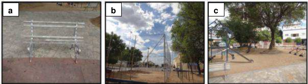
Figura 25 – Praça Alcides Carneiro: (a) Bancos quebrados; (b) Quadra de esportes; (c) Playground .
