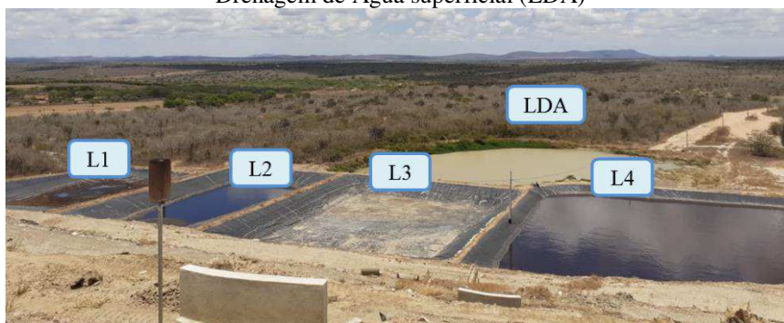
Figura 12 - Vista superior das Lagoas de Tratamento de Lixiviado (L1, L2, L3 e L4) e da Lagoa de Drenagem de Água superficial (LDA)
