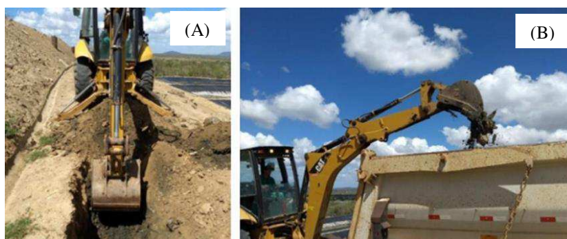
Figura 15 - Amostragem dos RSU aterrados: (A) Coleta e; (B) Transporte
