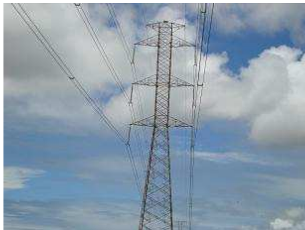
Figura 3.6 Estrutura de suspensão – Foto Chesf Luiz Carlos
