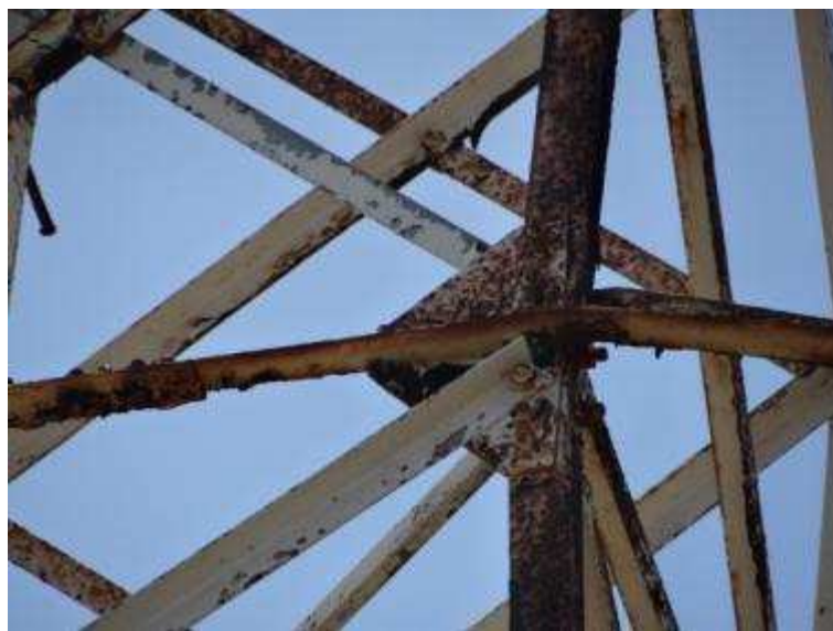
Figura 3.19 – Perda de massa em estrutura de LT – Foto Chesf Cleuber
