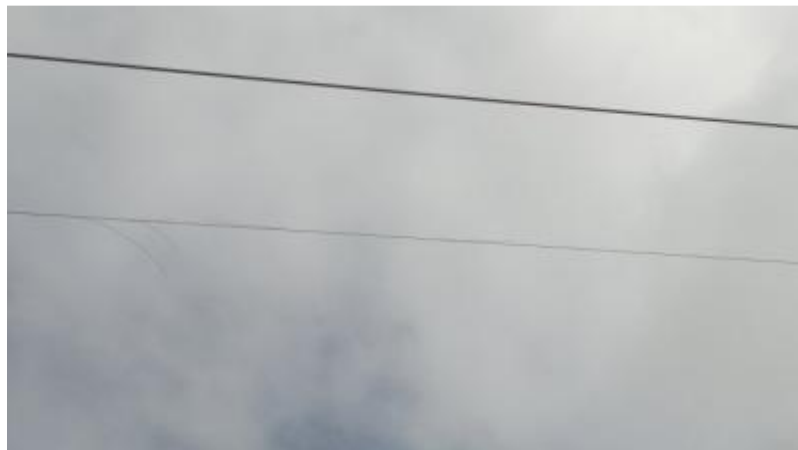
Figura 3.54 – Cabo pararraio com tento partido. Foto Chesf Josué.
