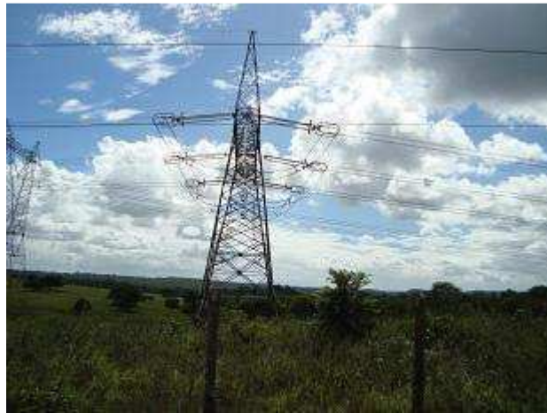
Figura 3.7 – Estrutura de ancoragem – Foto Chesf Luiz Carlos
