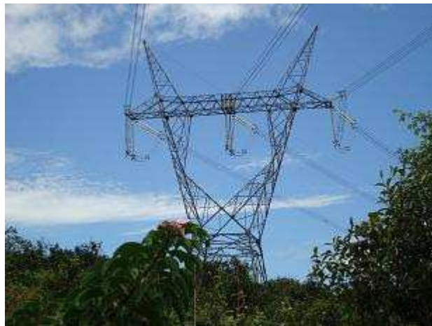
Figura 3.8 – Estrutura em ângulo (ancoragem) – Foto Chesf Luiz Carlos
