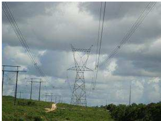
Figura 3.11 – Estrutura de transposição – Foto Chesf Luiz Carlos
