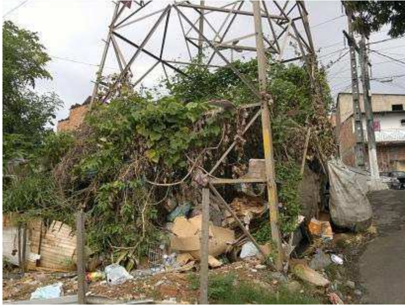
Figura 3.16 – Interferência de terceiros. Foto Chesf Cleuber
