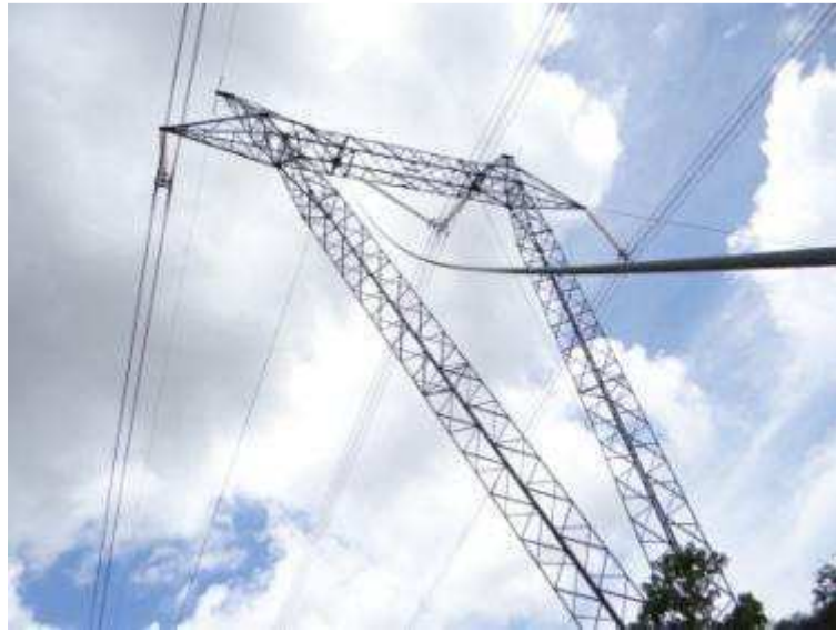
Figura 3.14 – Estrutura estaiada. Foto Chesf Josué Joaquim.
