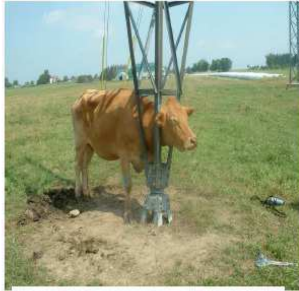
Figura 3.18 – Interferência de terceiros. Foto LIMA, 2012
