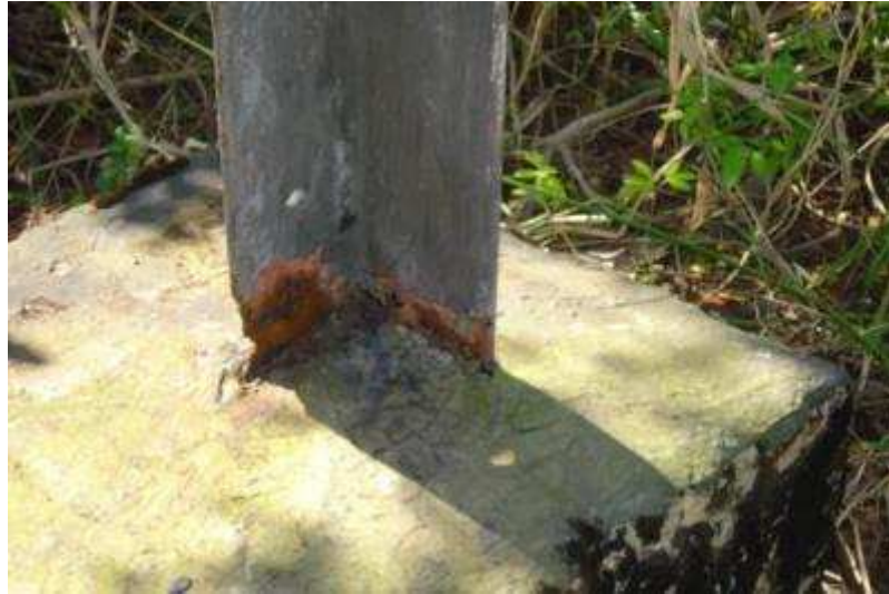
Figura 3.20 – Pé de estrutura metálica oxidada – Foto Chesf Cleuber.
