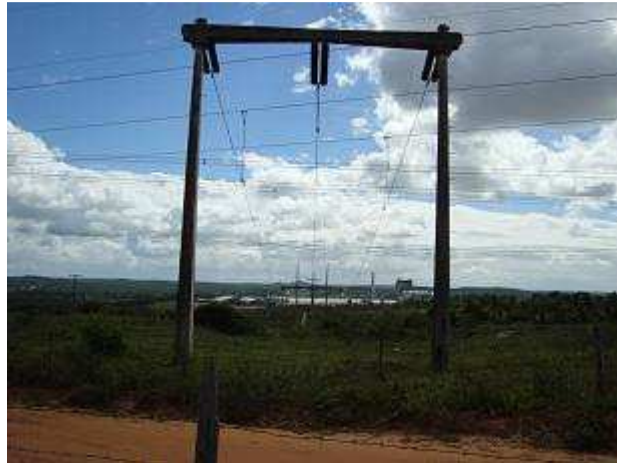
Figura 3.10 – Estrutura de derivação – Foto Chesf Luiz Carlos
