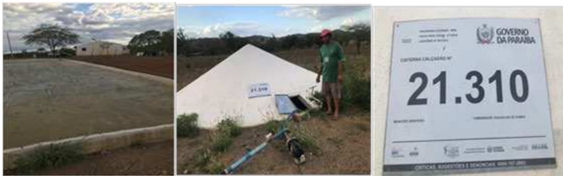
Figura 19: Cisterna calçada no sítio Limpo Branco, Monteiro-PB
