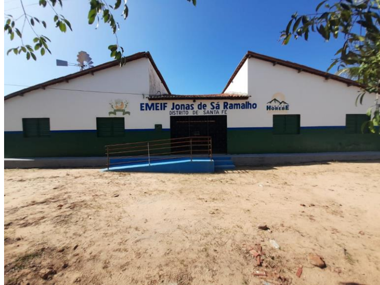
Figura 4. Escola Jonas de Sá Ramalho no distrito de Santa Fé – Monte Horebe - PB.
