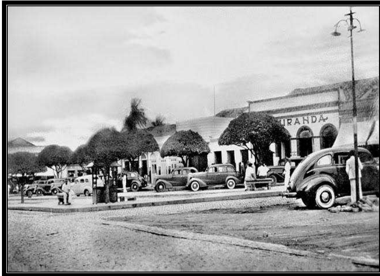
FOTOGRAFIA 4 – Imagem da Praça Epitácio Pessoa FONTE: Site Retalhos históricos de Campina Grande
