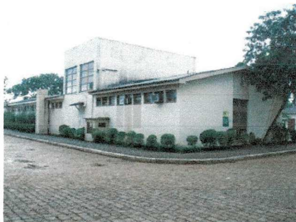
Fig. 1. Laboratório de Patologia Veterinária da UFSC - RS. Vista externa.
