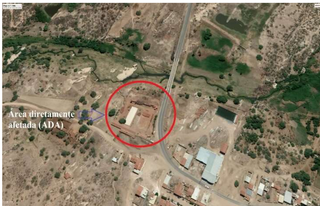
Figura 3- Localização da área diretamente afetada (ADA).
