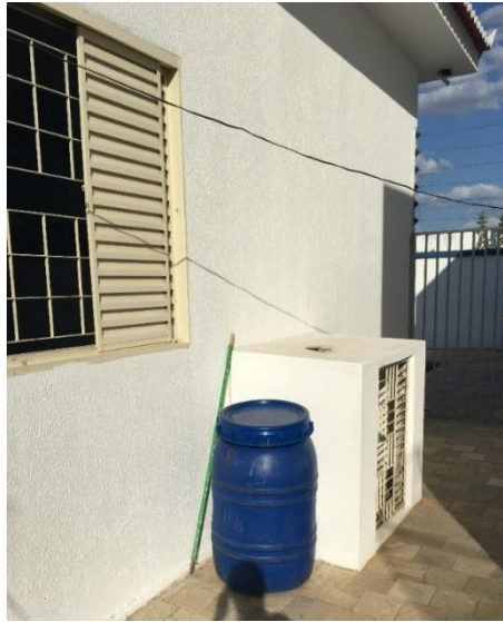
Figura 11 – Bombona de armazenamento temporário na UBS João de Sousa Leite
