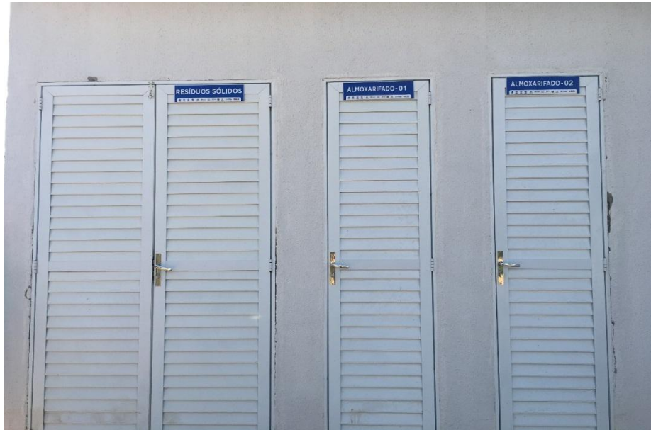
Figura 9 – Local de armazenamento externo da UBS Ademar Pereira Vieira
