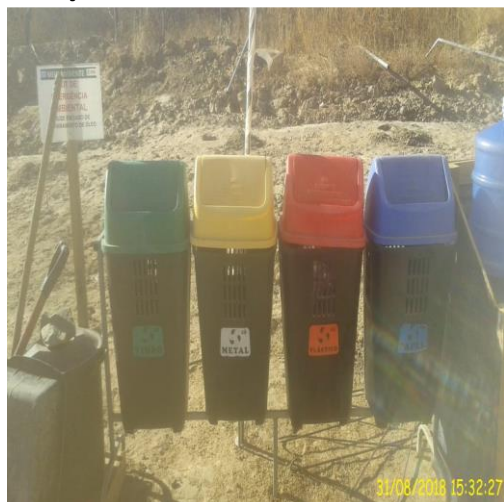
FIGURA 13 - Coletores nas frentes de Serviço
