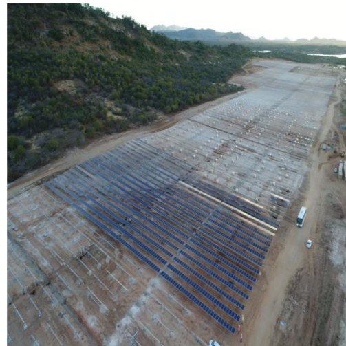
FIGURA 03 - Inicialização da instalação dos painéis fotovoltaicos
