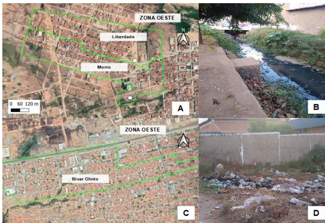
Figura 25 – Situação sanitário atual da Zona Oeste de Patos (PB)
