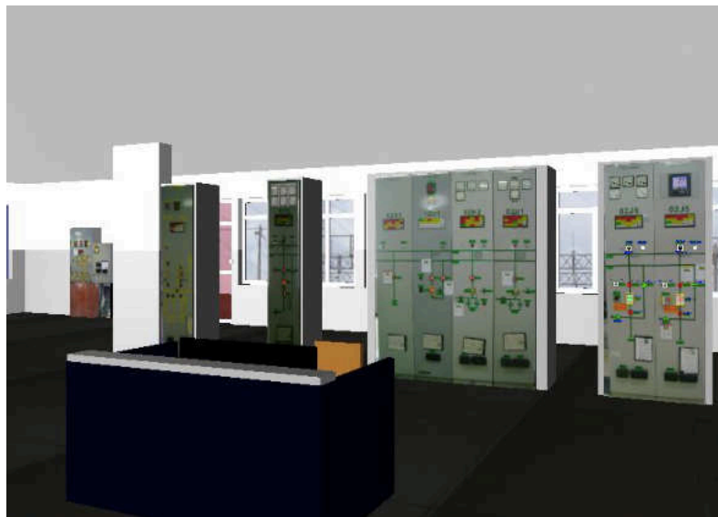
Figura 42: Ambiente virtual representando a sala de controle de uma subestação elétrica
