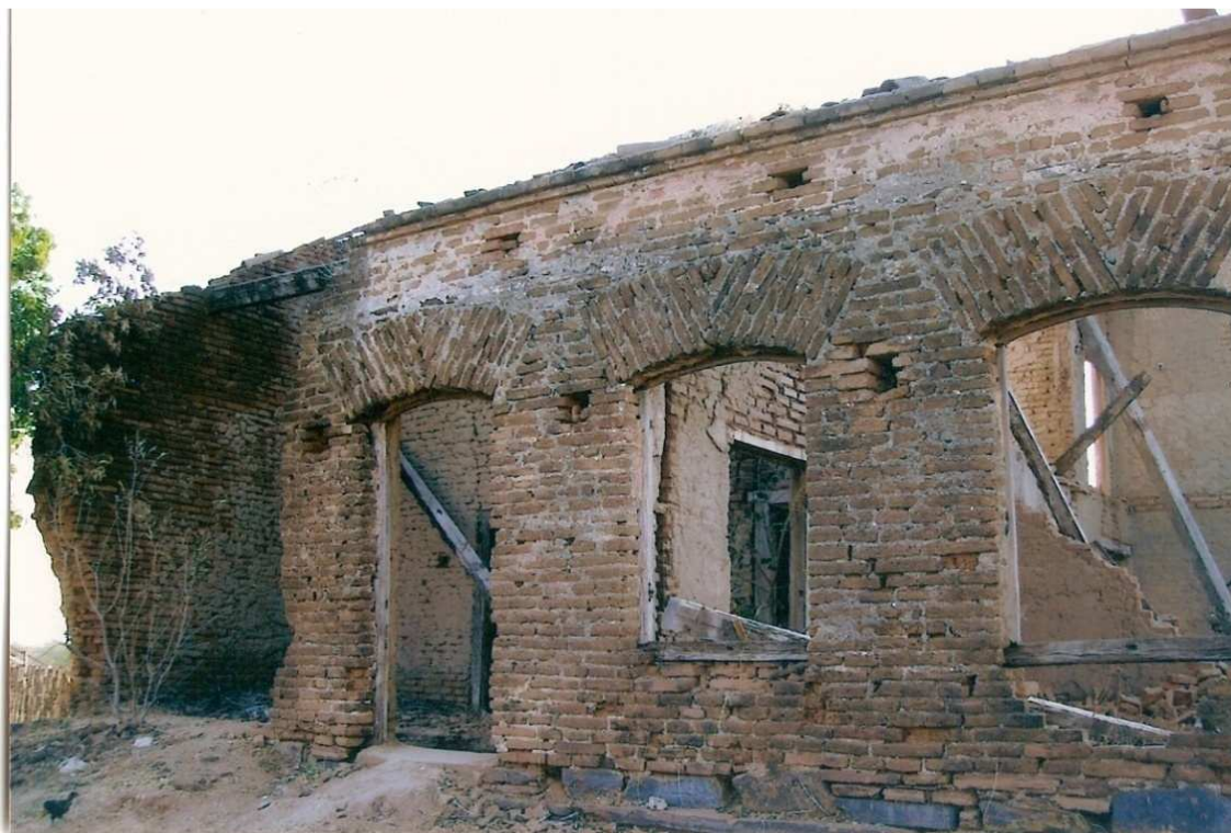
FIGURA 14: Ruínas da Casa Grande do Major João Gonçalves Dantas – Sítio Engenho Novo
