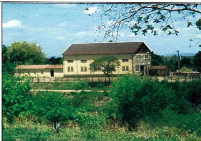
Ilustração I: O prédio principal, mais alto, é a Casa-de-Força. De lá eram propagados os apitos que norteavam os trabalhadores da Comunidade de São Gonçalo. A estrutura é a mesma da do tempo em que acontece o desenrolar de A Barragem .
