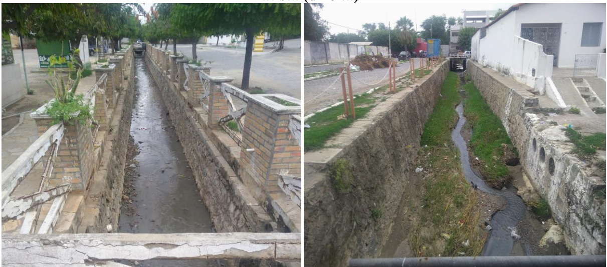
Figura 9 - Galeria na rua Felipe de A. Pereira (esquerda) e Galeria na Rua Hermogenes Batista (direita)
