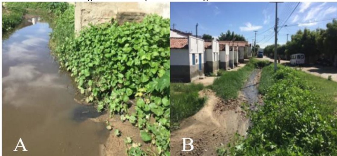
Figura 11 - Lançamento de Esgoto in natura
