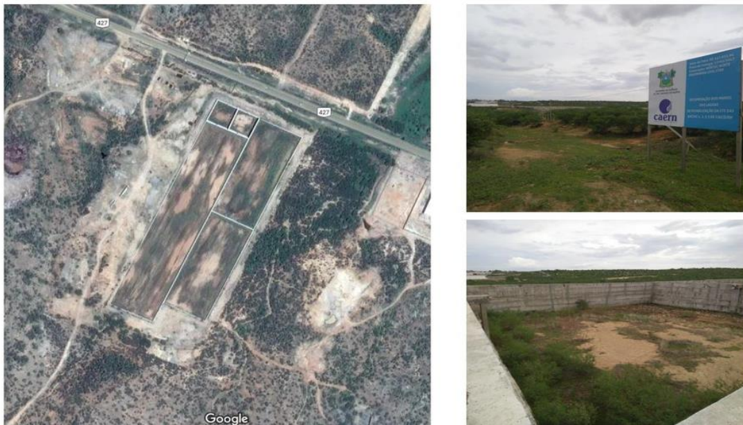
Figura 17 - Lagoas de estabilização: ETE das bacias 1, 2 e 3
