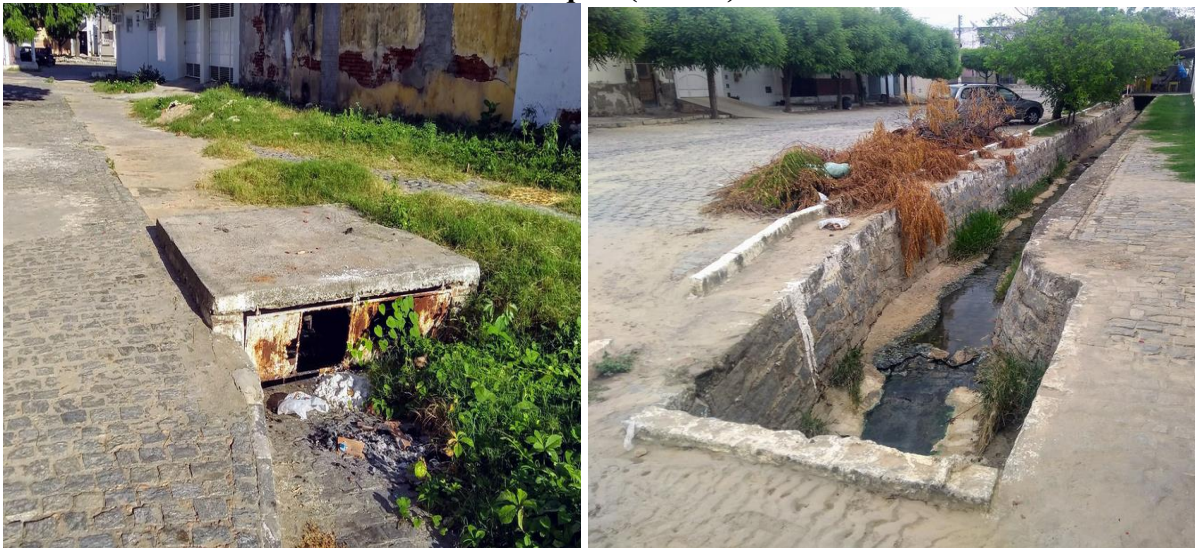
Figura 8 - Galeria na Rua Quintino Bocaiúva (esquerda) e Galeria na Rua José Eustáquio (direita)
