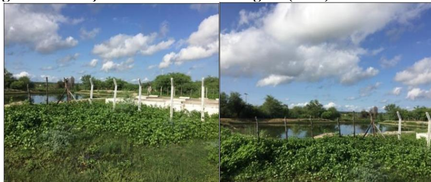
Figura 5 - Estação de tratamento de esgoto (ETE) – Castelo Branco
