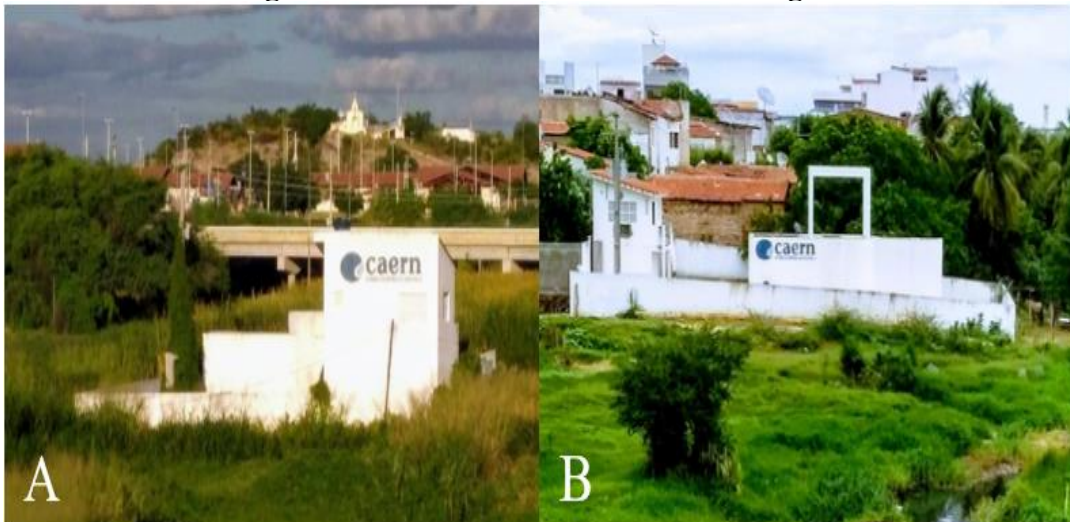
Figura 16 - Bases de bombeamento de esgoto
