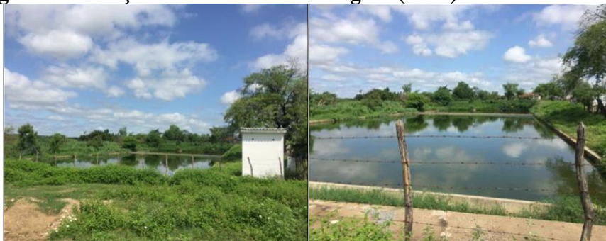
Figura 4 - Estação de tratamento de esgoto (ETE) – Vila do Príncipe
