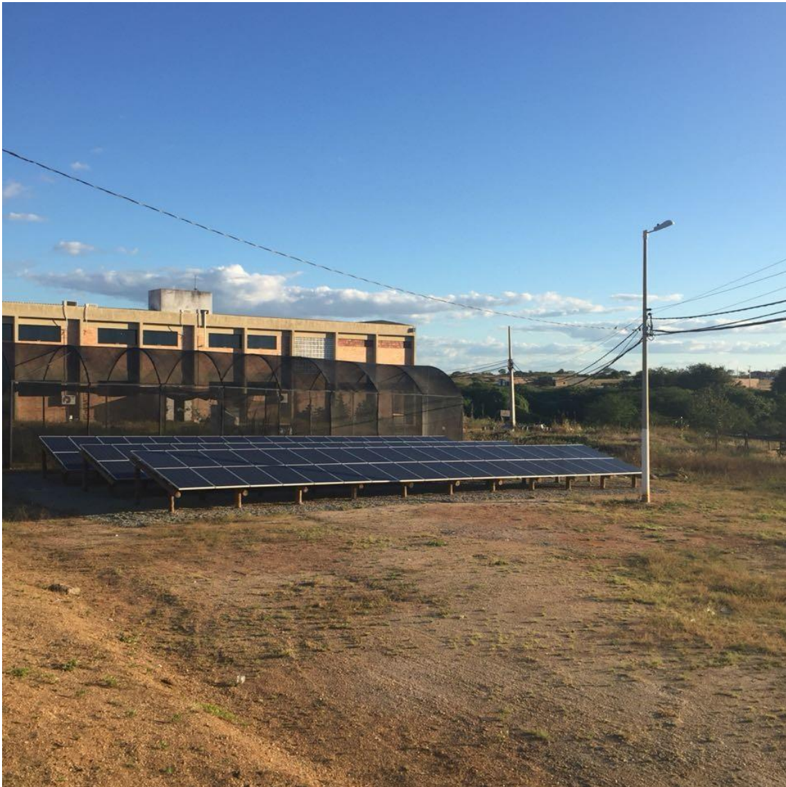
Figura 2 – Vista da área de instalação da UFV (Fonte: Autoria própria, 2018).
