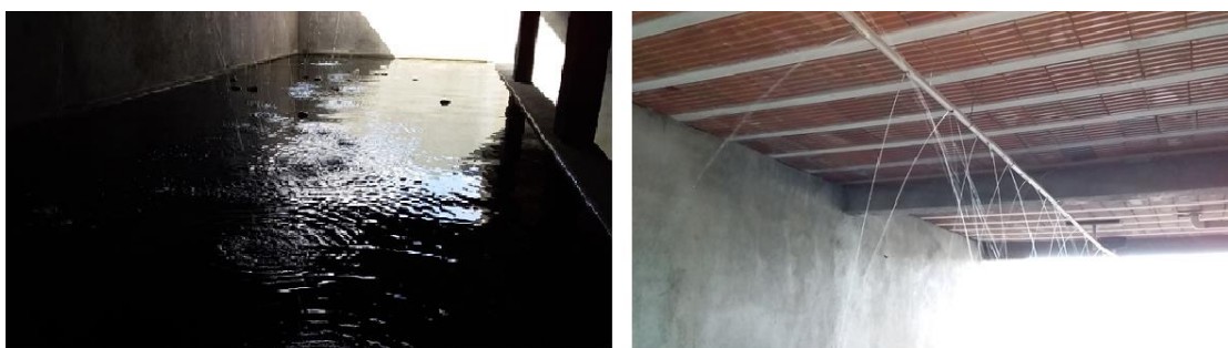
Figura 14 – Reservatório para criação de peixes com sistema de aeração.
