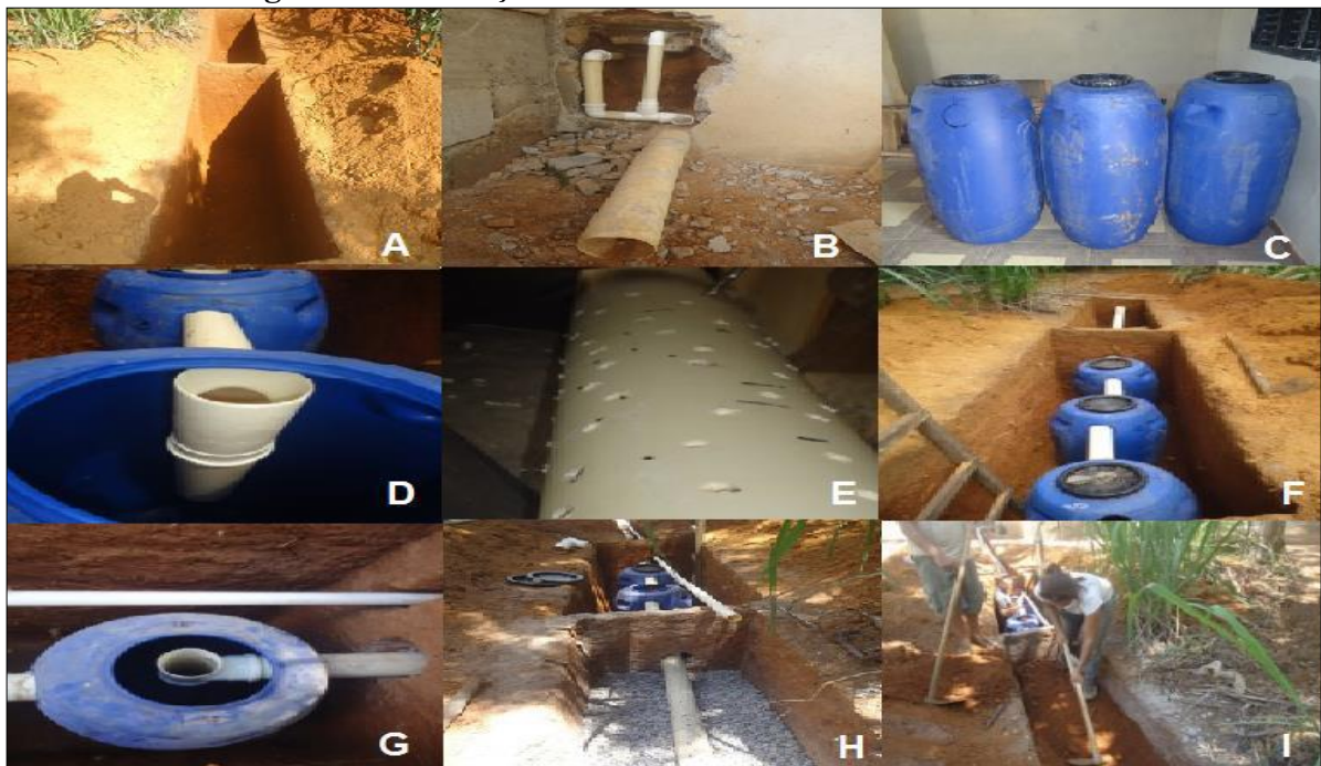
Figura 7 - Instalação do sistema com material alternativo
