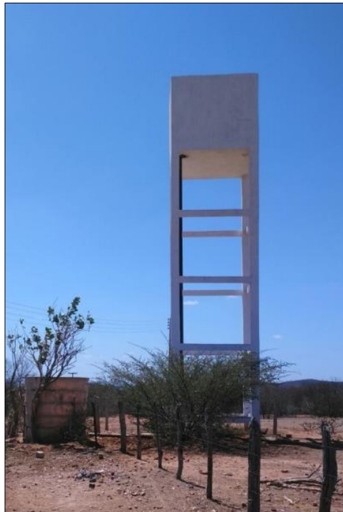
Figura 11– Reservatório elevado e antigo reservatório apoiado
