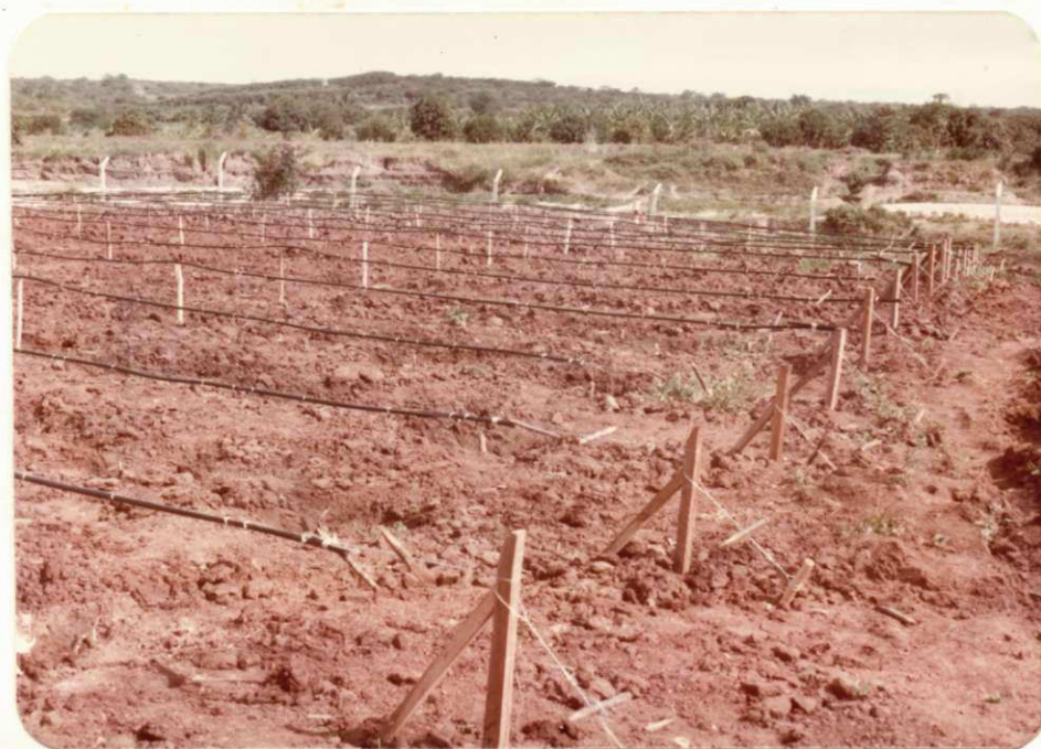
Fig. 24 - Fotografia das linhas laterais, fixadas nas extremidades com barroto de madeira.
