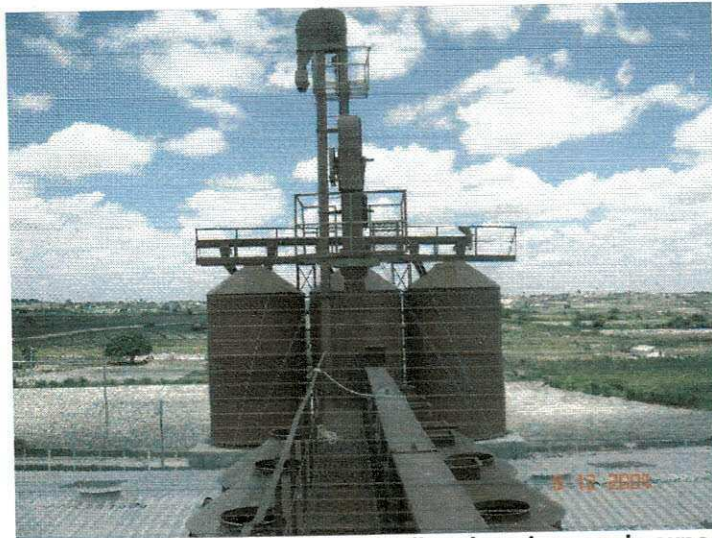
Figura 19 – Vista das passarelas dos silos dosadores e de expedição
