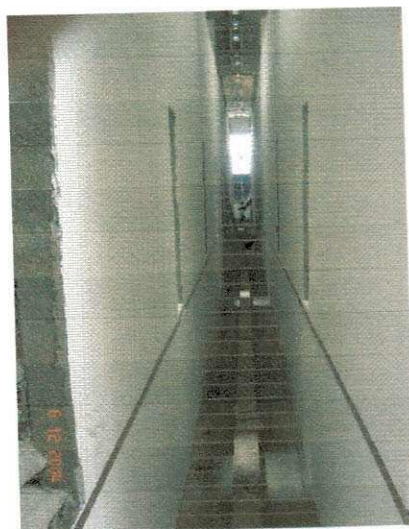
Figura 18 – Túnel central de descarga
