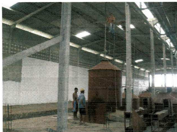
Figura 4 – Montagem dos silos dosadores
