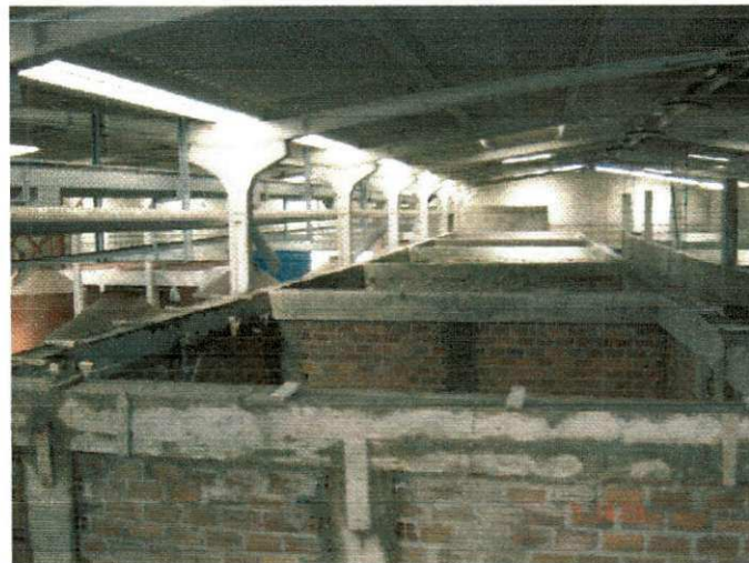
Figura 10 – Concretagem final de pilares e vigas dos silos.
