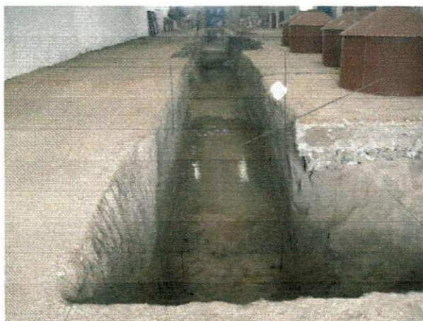
Figura 3 – Fundação do túnel e área dos Silos
