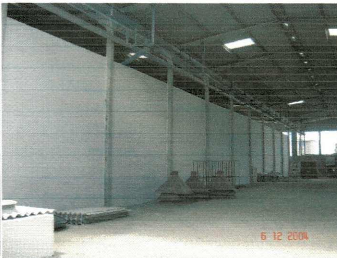
Figura 26 – Vista lateral da unidade armazenadora
