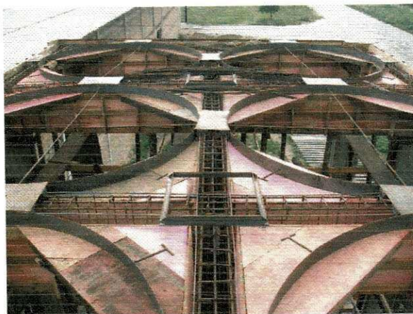
Figura 8 – Estrutura dos Silos de expedição
