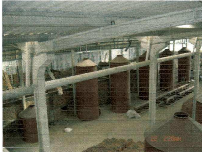
Figura 9 – Vista geral do elevador EL4, nível da coberta.
