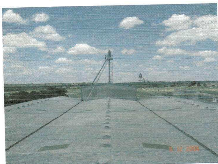
Figura 17 – Elevador 1, cobertura da fábrica e recepção dos grãos
