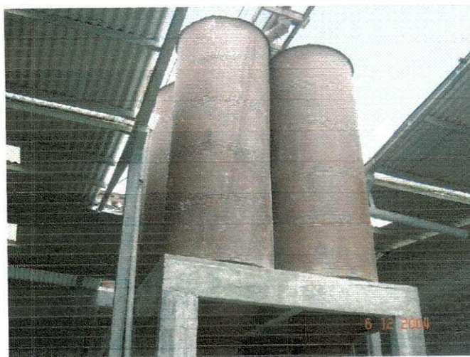
Figura 13 – Instalação final dos silos dosadores
