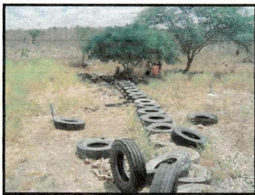
Figura-7-Panorama da Barragem 3 no Período da Construção.
