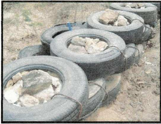
Figura-3-Barragem-1, com detalhamento das pontas das varas de ferro virada e pedras dispostas na ultima camada.
