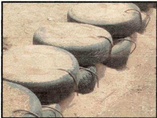
Figura-5-Barragem 2 com detalhe do preenchimento de areia na ausência de pedras.
