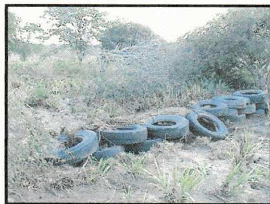
Figura-8-Trecho da Barragem 3 na calha do riacho após as primeiras chuvas do local, mostrando o "emborcamento" de um único pneu.
