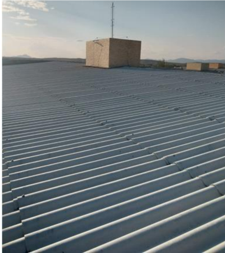
Figura 20 - Telhado do Bloco 3.
