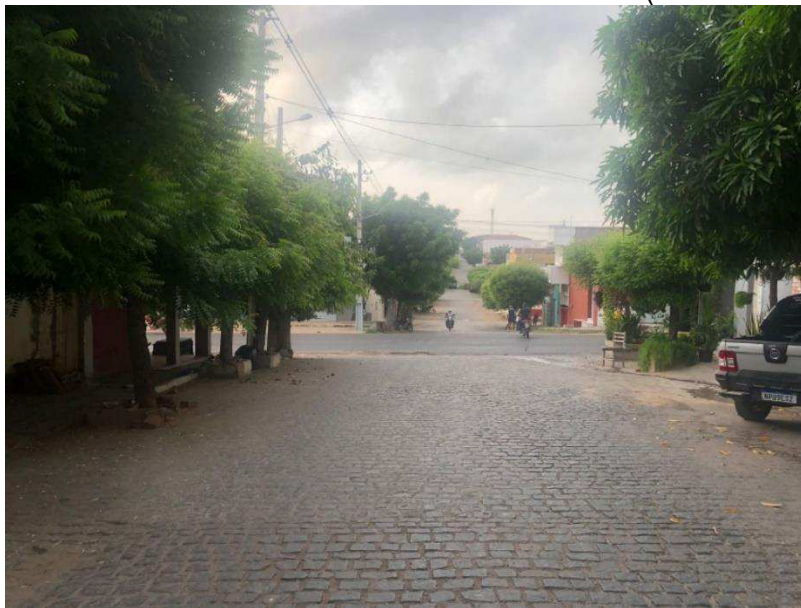
Figura 13 – Vista da Via Francisco de Paula Saldanha (Sentido: Norte – Sul)
