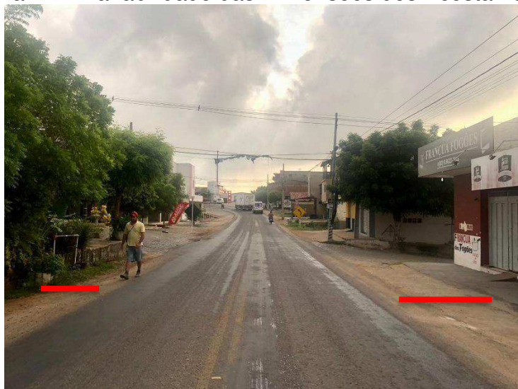
Figura 14 – Variabilidade das Dimensões dos Acostamentos
