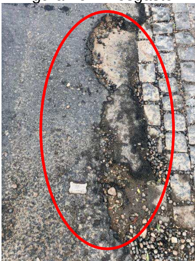
Figura 16 – Desgaste
