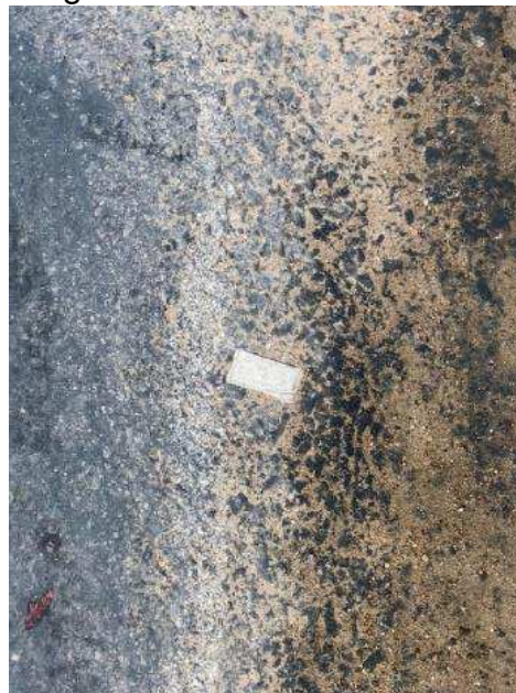
Figura 22 – Tacha Danificada
