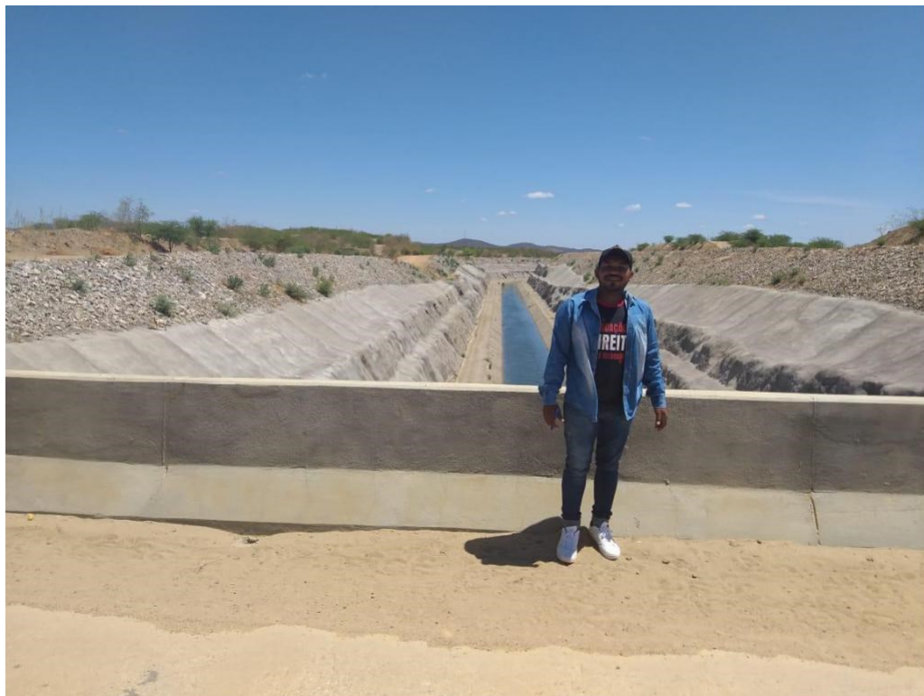
Figura 14 - Visita ao Canal da Transposição na Comunidade Pau D'arco no Município de Monteiro - PB
