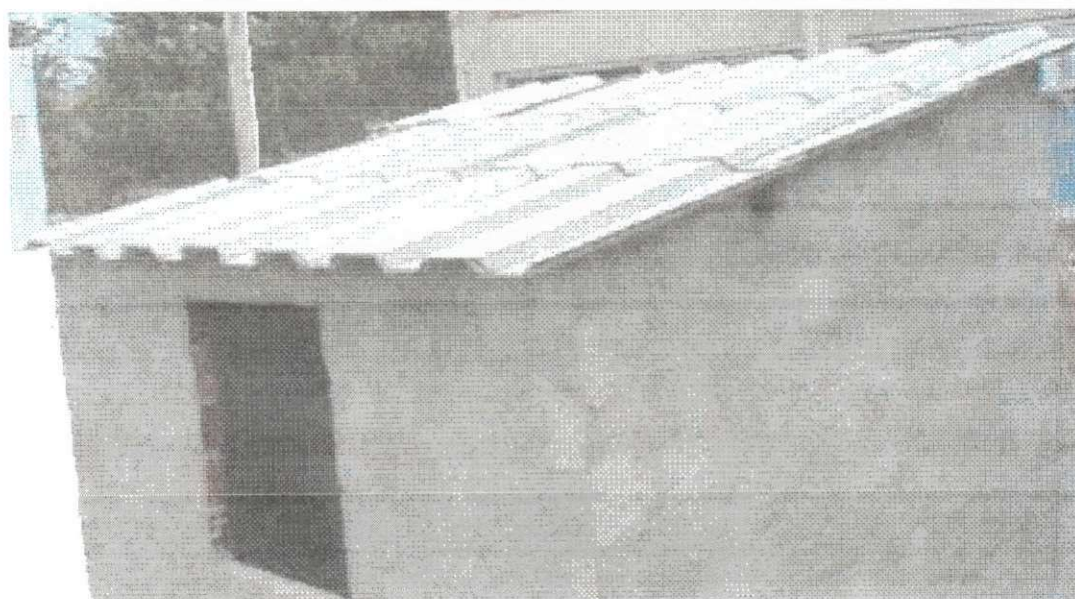
FIGURA 4.3 – Telhas submetidas ao envelhecimento natural sob condições de uso no modelo em escala real
