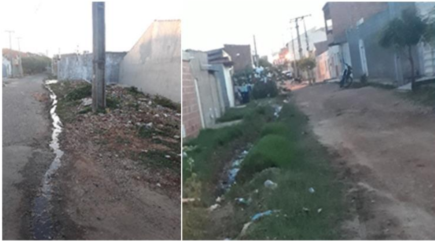
Figura 7. Esgoto a céu aberto.
